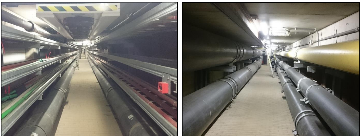
Figuur 1: De zuid-gang (links) en de noord-gang (rechts) van de ILT Zuidas
