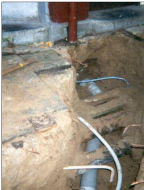
Figuur 6: Problematiek van maken van huisaansluitingen
