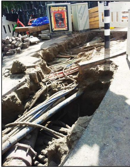
Figuur 2: Voorbeeld ligging kabels in de ondergrond
