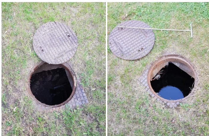
Figuur 18: Links de put waarin het water wordt verzameld dat naar het helofytenfilter gaat, rechts de put met water dat door het helofytenfilter is geweest
